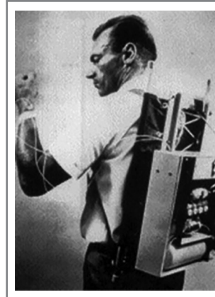
Рис. 2. Первый прототип инсулиновой помпы Арнольда Кадеша (1963 г.) [7].
